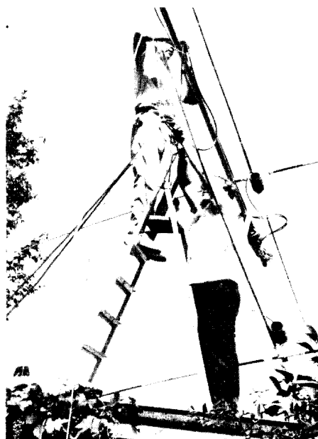
Fig. 33. De kabels worden langs de mast geleid en bevestigd met tie-wraps. PA0SE weet hoe je dat het beste kunt doen! Op de ladder Ton, PA2ABV; Jos, PA3ACJ, assisteert. Niet op de foto's, maar wel aanwezig, was Cor, PE0CVL.
